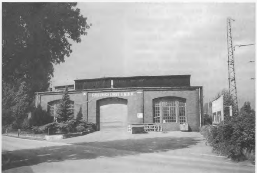
Alter Ringlokschuppen des früheren Bahnbetriebswerkes Ratingen-West
