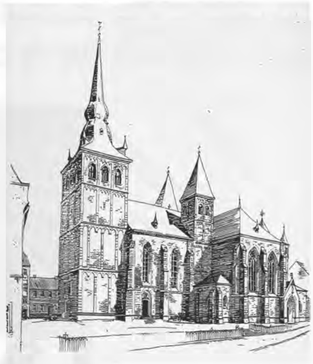
So zeigte sich St. Peter und Paul nach dem Umbau vor 100 Jahren. Hochchor und Querschiffe sind neu hinzugekommen. Alle Fenster haben jetzt steinernes Maßwerk. Das Mauerwerk ist restauriert und die beiden romanischen Türme (Osttürme) tragen neue Turmhelme. (Zeichnung: Kaplan Günter Ernst)
