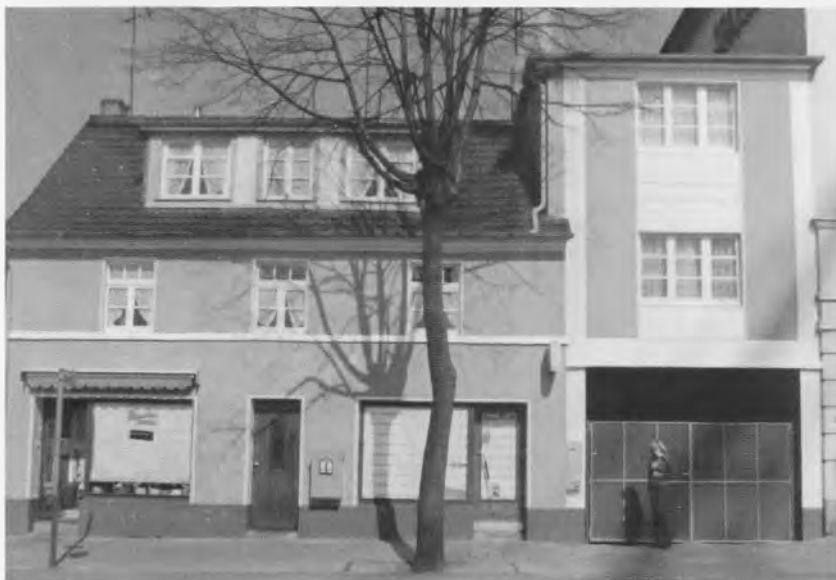
Die Stellmacherei Schorn in den 60er Jahren. Rechts der Torweg-Überbau von 1934. Das Haus wurde 1987 an die Sparkasse verkauft und 1990/91 abgerissen
